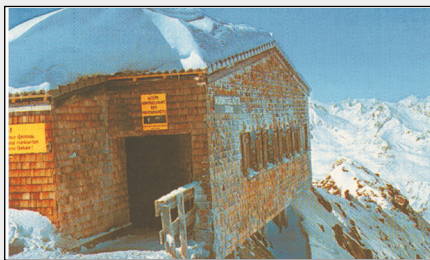
Berghütte in 3080 m Seehöhe seit 1994 mit Rezyrit - Pfanne gedeckt
